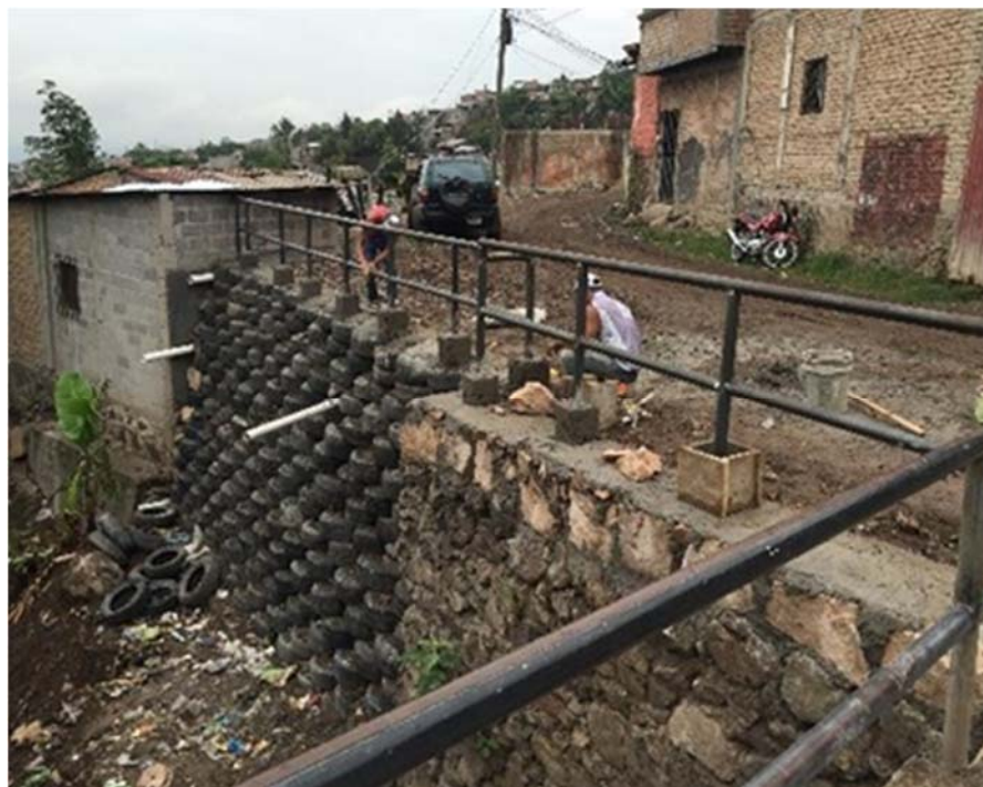
Construcción de Barandal metálico con dados de concreto
